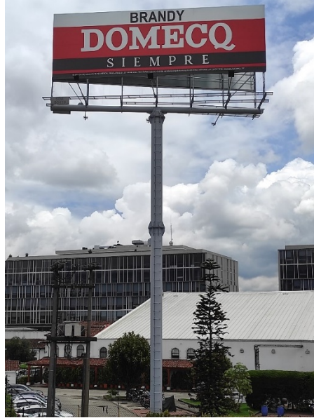
Foto 2. Vista del panel orientación Este - Oeste y de la estructura de la valla, en buenas condiciones y estable.
